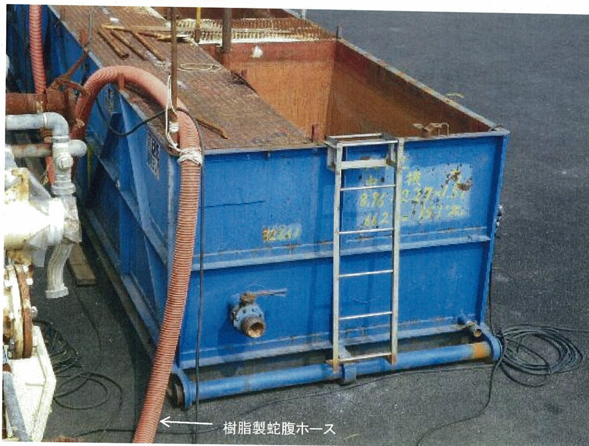
30kL角タンク上面及び梯子の状況
