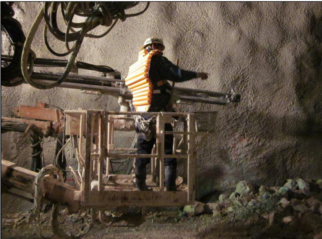
参考写真2 装薬作業で使用していたドリルジャンボのマンケージ部
