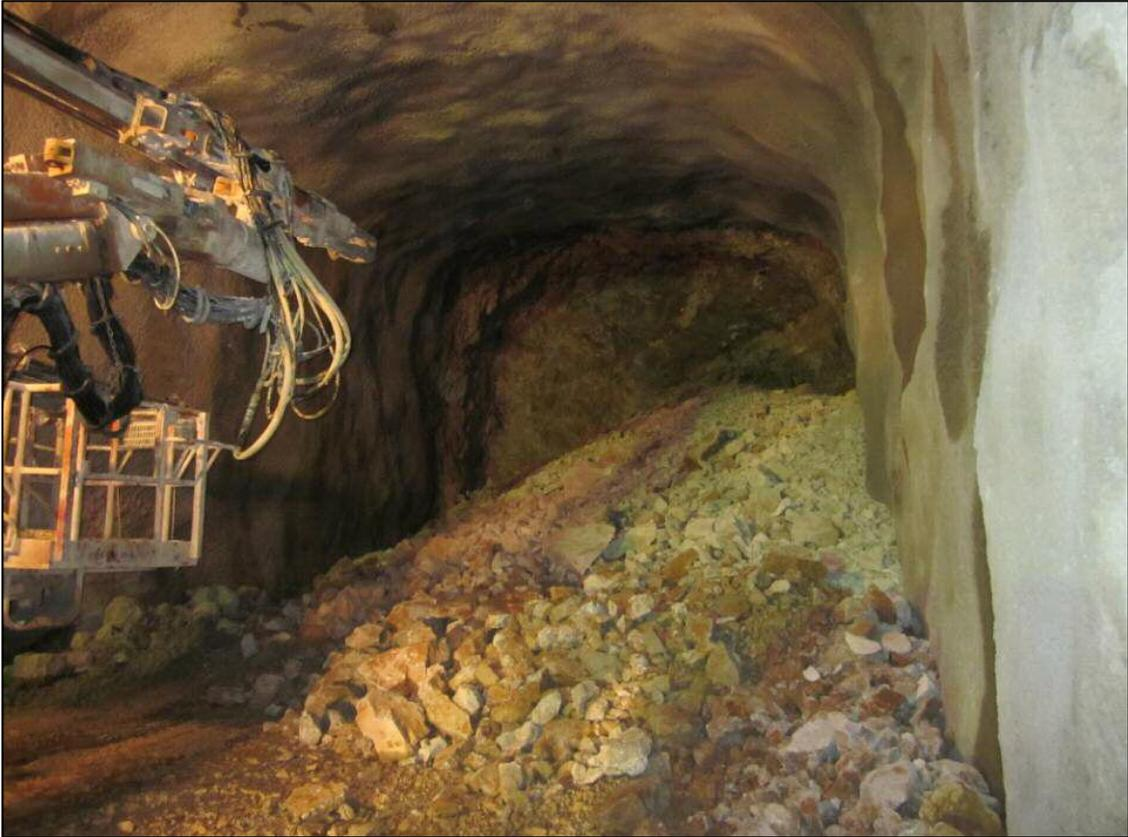
参考写真1 ベルトコンベア坑道の様子 (幅6.8m 高さ5.5m)
