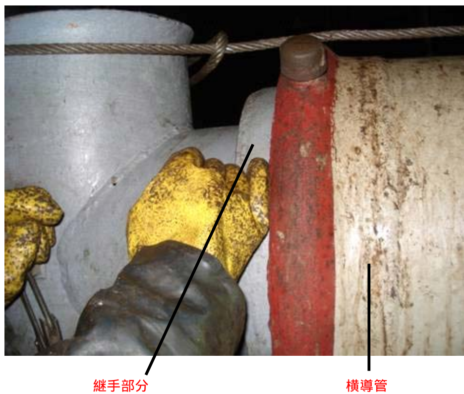
噴出防止設備側の継手部分（ベルニップル）と横導管に右小指が挟まった際の状況写真
