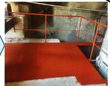
改善後(腐食部を補強)
