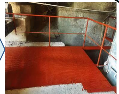
改善後(腐食部を補強)
