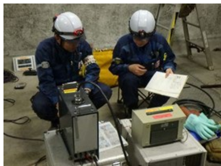
ケーブル劣化診断
