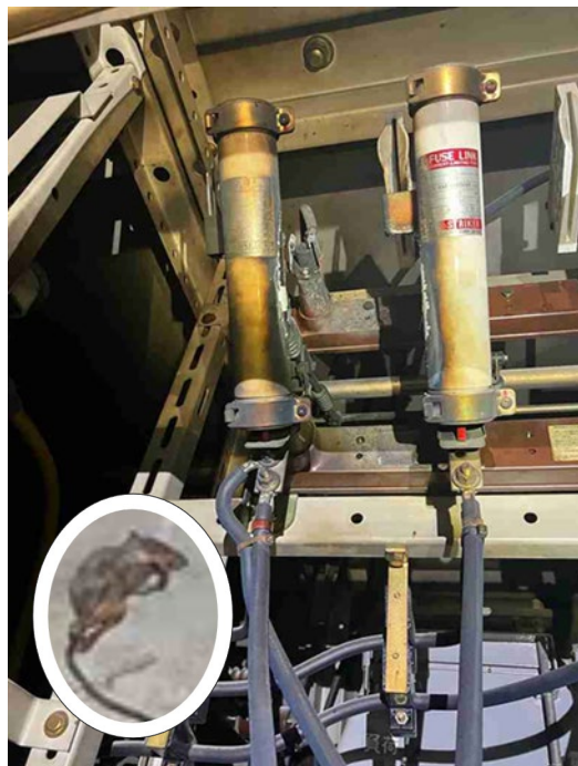
LBSにて短絡したネズミ【左】とトカゲ【右】
