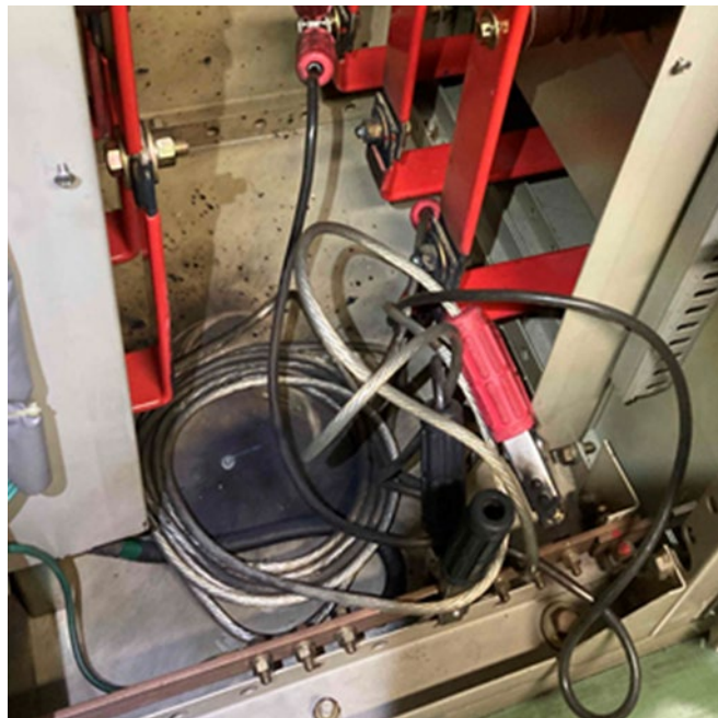
短絡によって焦げた床面
