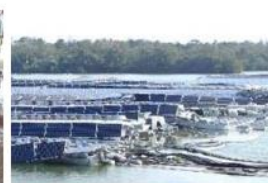
太陽光発電設備崩壊 (暴風)
