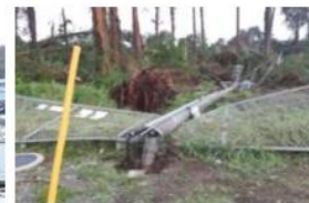
構内柱倒壊 (暴風・倒木)
