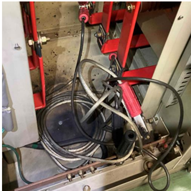
短絡によって焦げた床面
