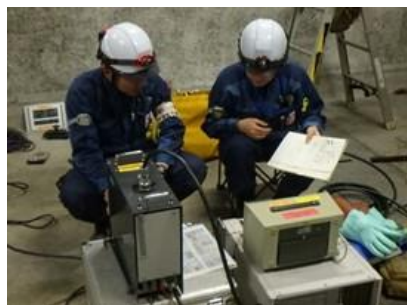
ケーブル劣化診断
