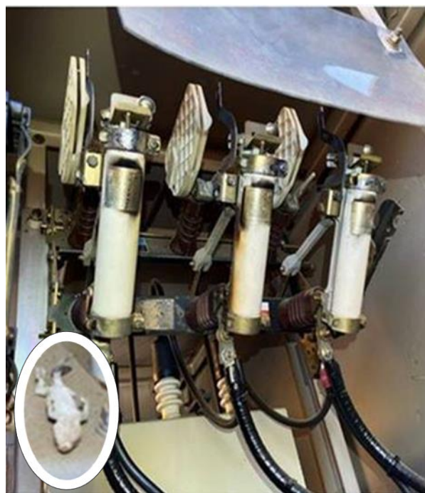
L B Sにて短絡したネズミ【左】とトカゲ【右】
