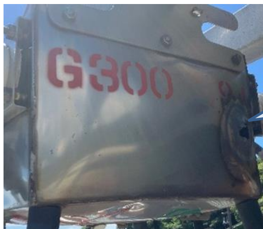
錆による区分開閉器破損(施設後約30年)
