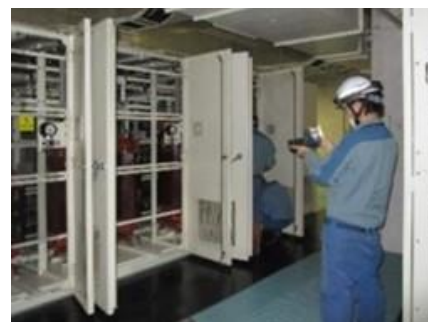
画像や測定器による機器劣化診断
