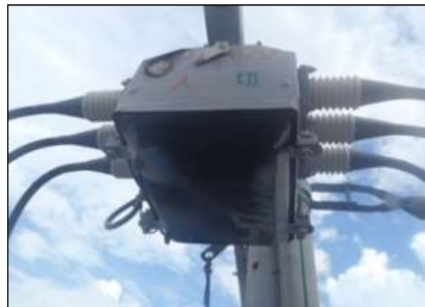
雷による区分開閉器内部短絡(避雷器内蔵無し)
