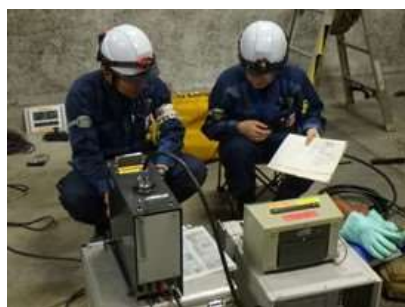
ケーブル劣化診断
