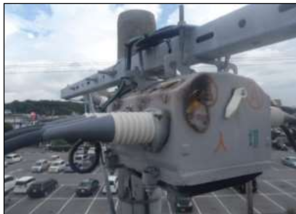
雷による区分開閉器内部短絡(避雷器内蔵無し)
