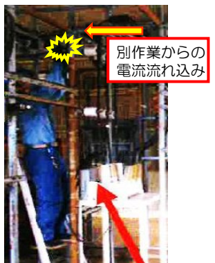
交換作業中に断路器に触れ感電
