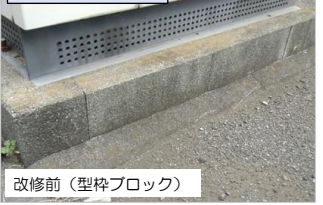
既設設備改修例
