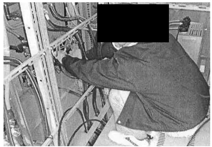
動力200Vブレーカーにケーブルの接続作業を実施していた。
