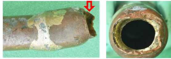
【事故容器の加圧コイル継手部き裂箇所(外径 8mm)】
