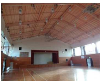
天井の落下防止対策
